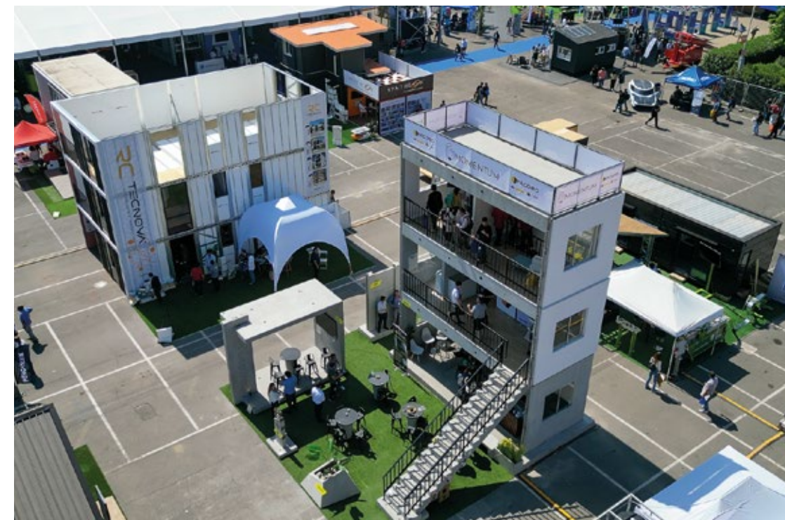
DEMOSTRACIONES CONSTRUCTIVAS A ESCALA REAL
