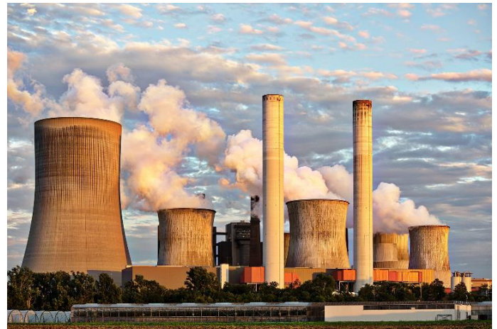
Kühltürme einer Industrieanlage.
